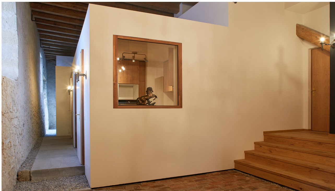
Fig. 2. Manège du château de Method, vue du rez-de-chaussée de la grande halle, avec ses espaces privés, chauffés, sous forme de "boîtes dans la boîte" (photo ZAK Andrea Zaccone).
