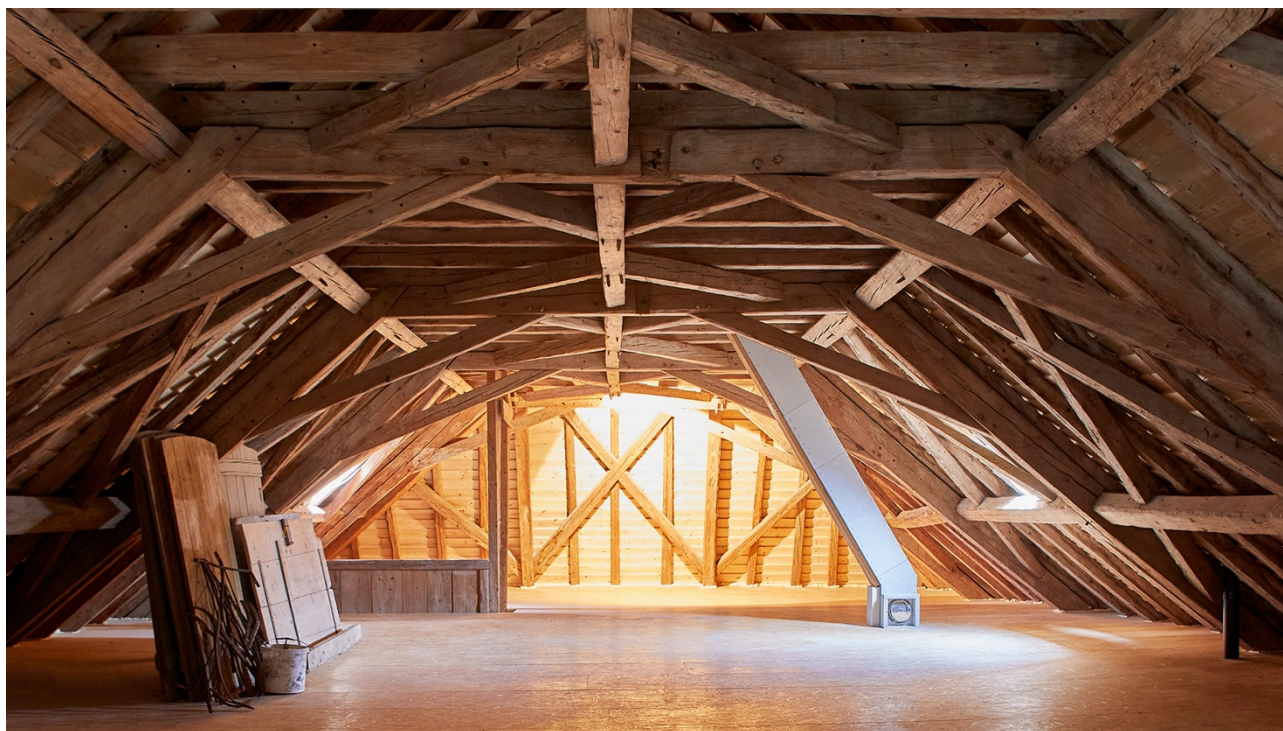
Fig. 3. Manège du château de Method, vue des surcombles (photo ZAK Andrea Zaccone).
