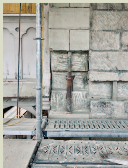
Fig. 8 - Travaux de façade, substitution de la pierre de molasse, 2021.
