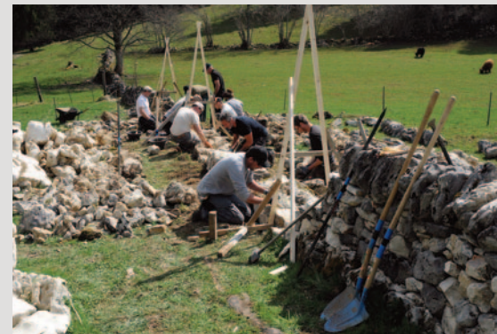
Fig. 6 - Val-de-Ruz. La Gentiane (Neuchâtel). Reconstruction d'un mur de clôture de pâturage durant un cours en 2015.
