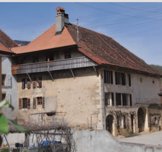
Fig. 3 - Bonvillars (Vaud). Crépi à la chaux lissé et badigeonné sur la façade gouttereau et projeté contre la façade pignon, vers 2010.
