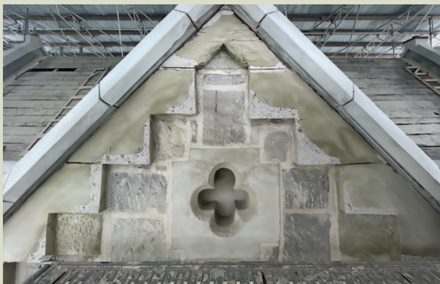
Fig. 7 - Éléments hybrides molasse-béton datant de la restauration de Jacottet, 2021.
