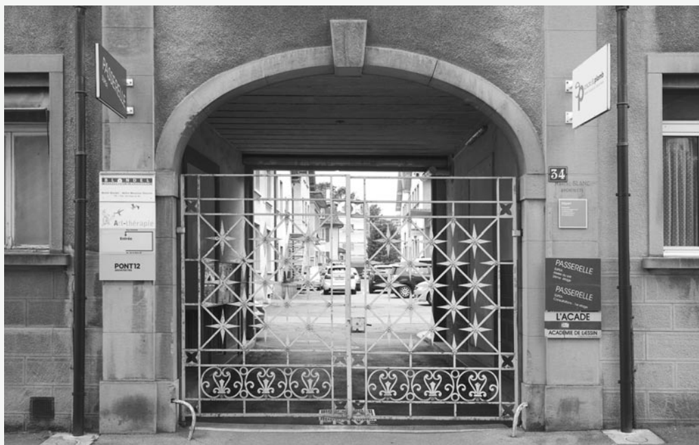
Fig. 5 - Portail principal sur l'avenue de la Gare réalisé lors de la deuxième extension de la fabrique à la fin des années 1930 par l'architecte Marcel Blanc.
