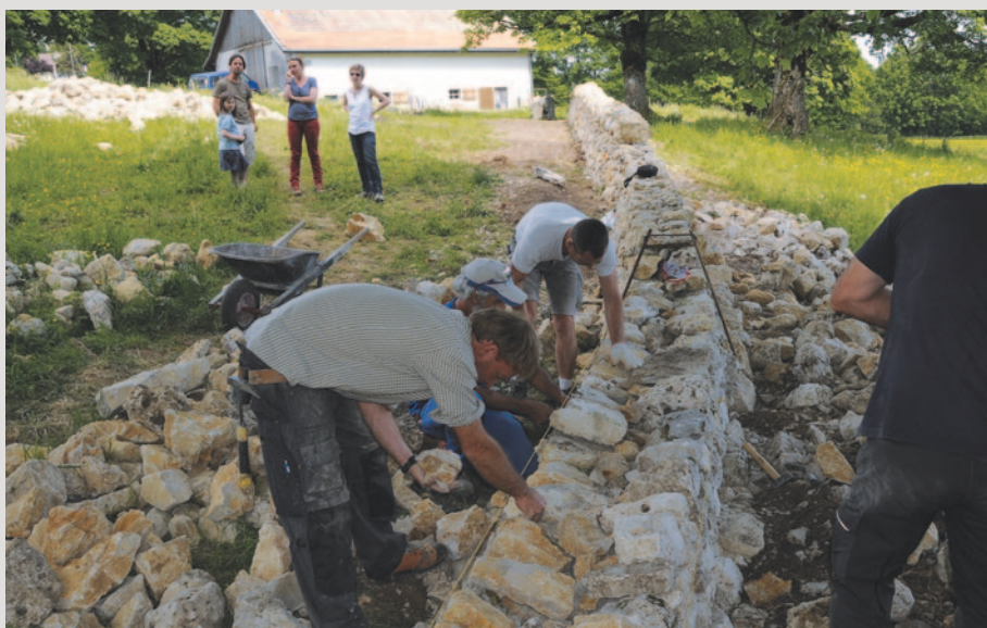
Fig. 10 - Val-de-Ruz, Montagne de Cernier, Les Patraux. Reconstruction d'un mur de clôture de pâturage
