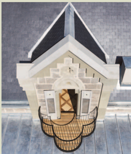
Fig. 10 - Ajout du balcon trilobé sur la galerie, juillet 2022.
