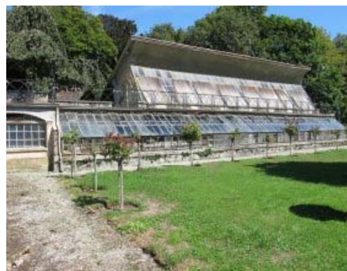
9. Château d'Hauteville Vue des serres Photo : Béatrice Lovis
